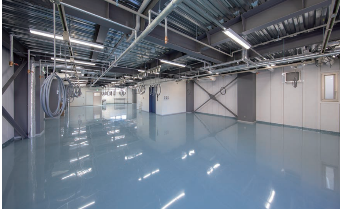
2階の工場スペース。製造効率を考え、壁のない大空間の作業エリアを設計。
